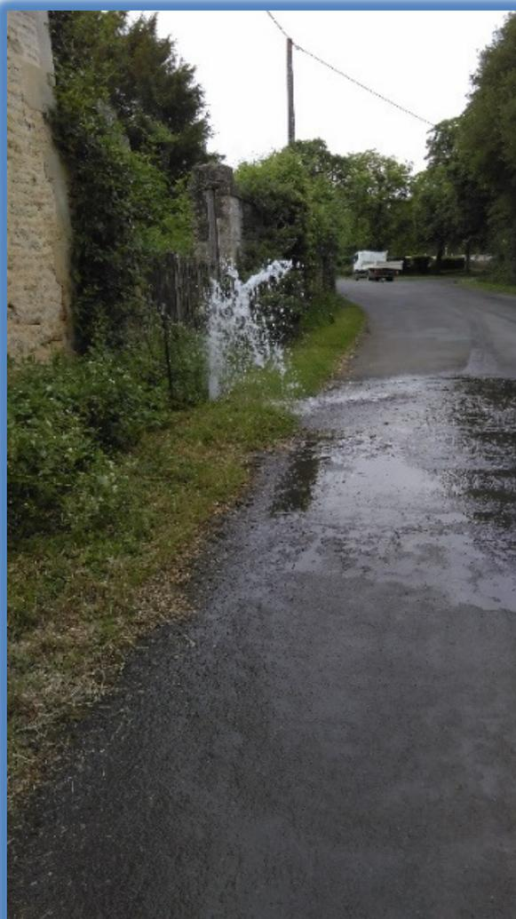
**Réalisation d'une purge sur le réseau**
